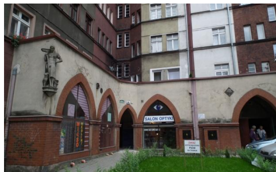
Fot. 2. Widok wejścia do kamienicy.
